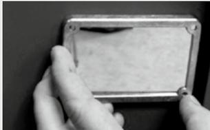
2. Führen Sie nun das Schloss von der Außenseite der Tür schräg in das Lochbild ein, so dass der Riegel hinter der Auflagefläche liegt.
